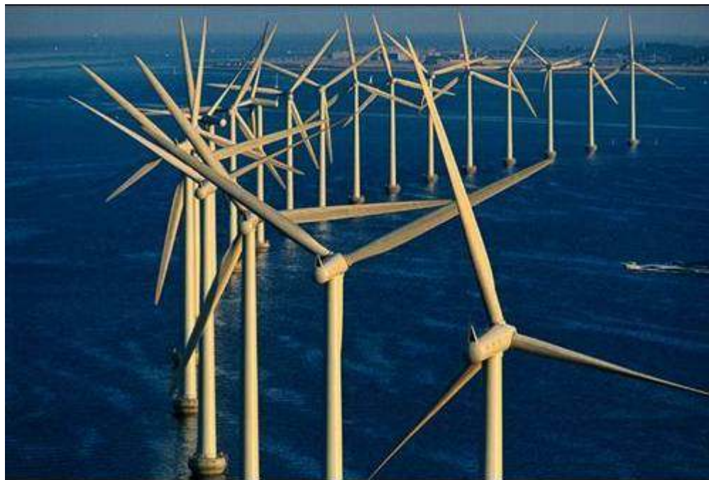
Parc éolien offshore au large du Danemark
